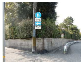
離宮から須磨寺への道路沿いの石積み擁壁
