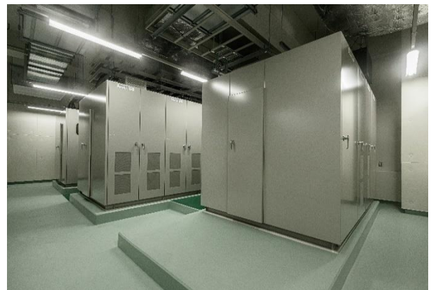
図4：高圧受変電設備工事
